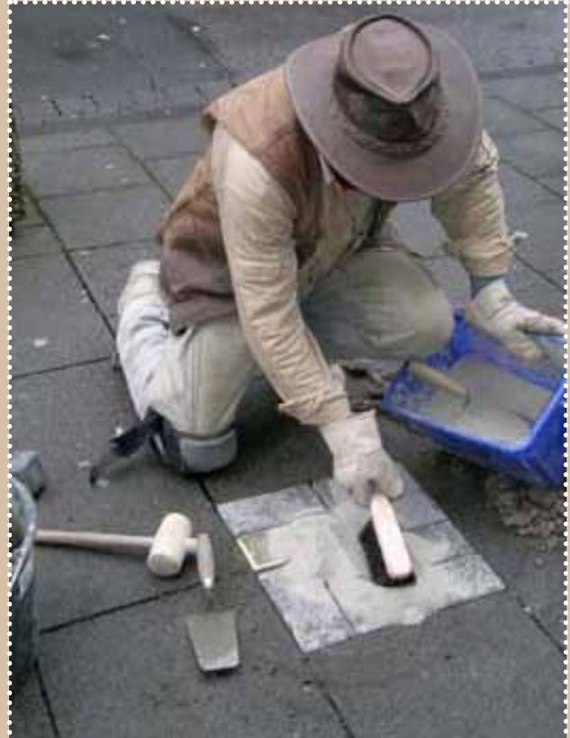
Jetzt füllt er die Fugen mit Zementmörtel aus.
