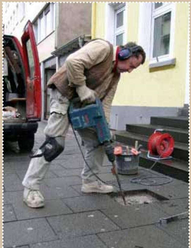
Dann lockert er den Betonboden mit dem Bohrerhammer.
