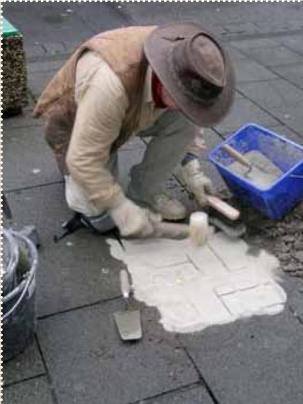
Zum Schluss verdichtet er den Beton, damit so wenig Luftblasen wie möglich vorhanden sind.
