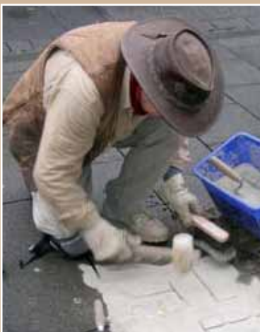
Als Nächstes bereitet er das Betonbett vor und füllt es mit Betonsteinen auf.
