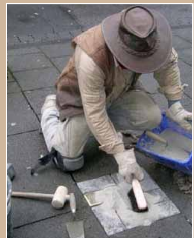
Jetzt füllt er die Fugen mit Zementmörtel aus.
