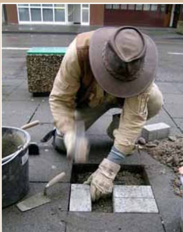
Als Nächstes bereitet er das Betonbett vor und füllt es mit Betonsteinen auf.
