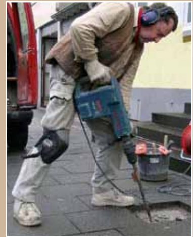
Dann lockert er den Betonboden mit dem Bohrhämmer.
